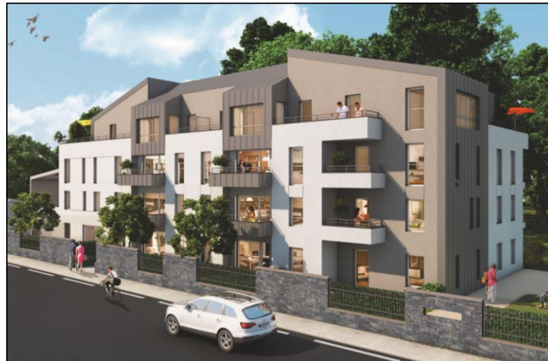
ANGERS - SCCV PRUNIER Collectif 20 logements
