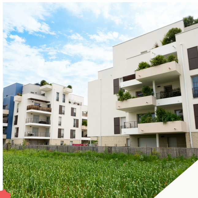
Résidence ELEMENTS Chambray-lès-Tours
