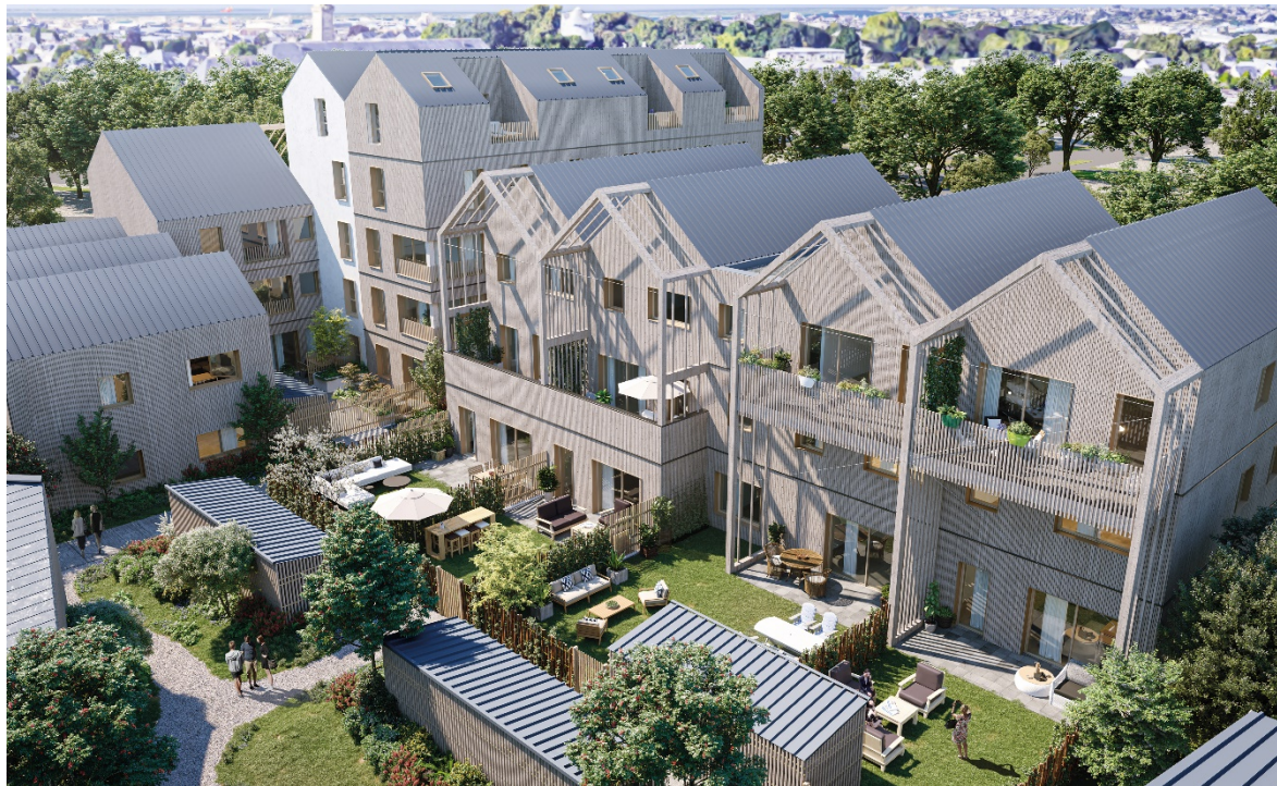
A Saint-Malo (35), « Carrousel », écoquartier de 70 logements, mixe dans sa conception matériaux anciens et biosourcés (livraison fin 2023).
