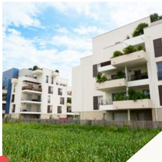
Résidence ELEMENTS Chambray-lès-Tours
